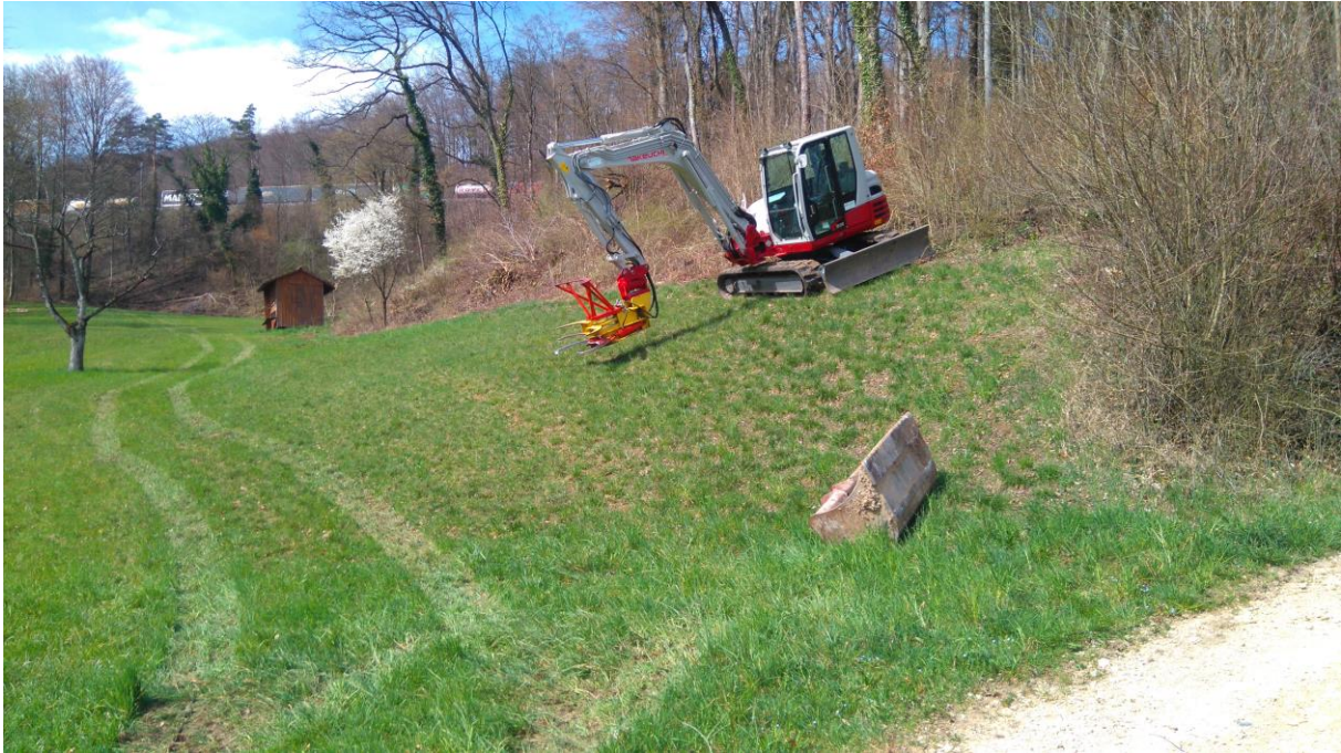
Der Bagger Takeuchi TB 290 in der Testphase.
